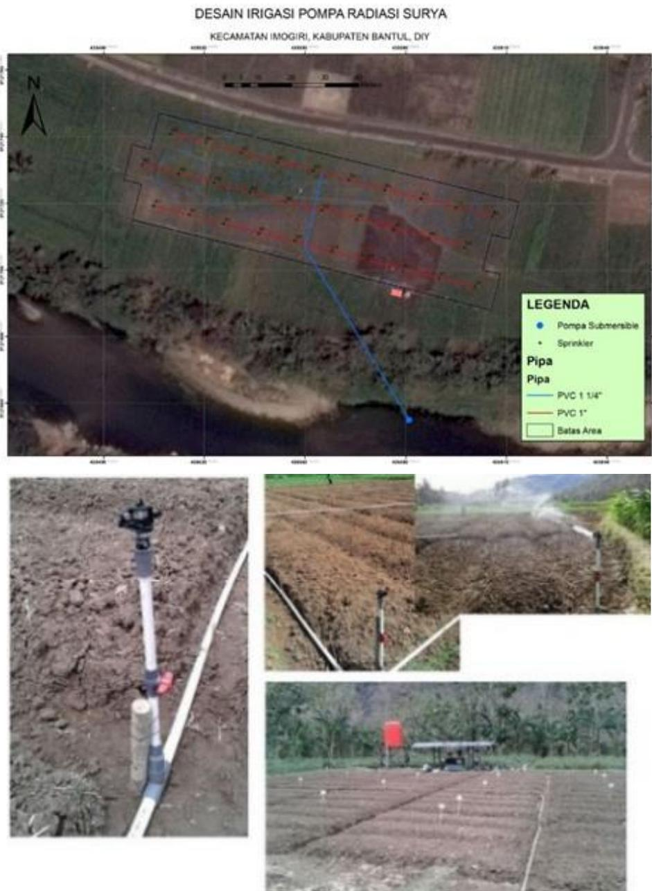
**Gambar 5** Desain dan Instalasi SIPTS Berbasis Teknik Irigasi *Impact Sprinkler*
