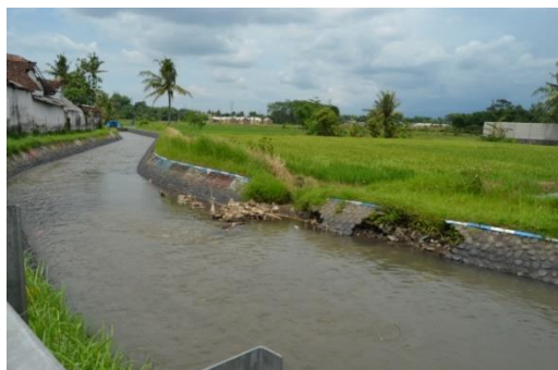
Gambar 3 Longsor pada R. KS. 5 pada DI Kertosari
