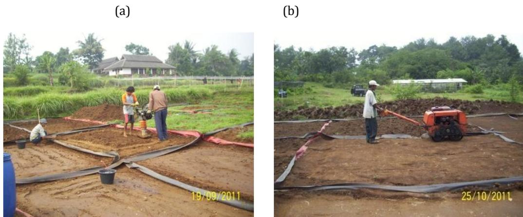
Gambar 2 Pemadatan dengan *soil stamper* (a) dan *baby roller* (b)
